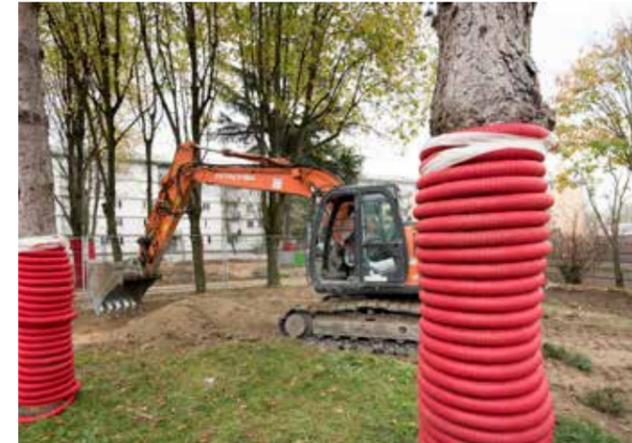
Les arbres situés à proximité des travaux sont systématiquement protégés des engins de chantier.
