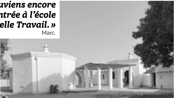
L'école maternelle construite en terre par Marc Held dans le village de Samba Dia, au Sénégal.
