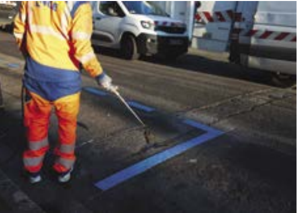
Renouvellement des marquages au sol.
