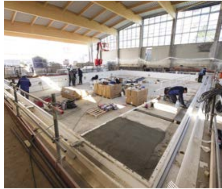
Les travaux de la piscine des Malassis avancent.
