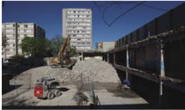
Démolition de la partie sud de la dalle Thorez après travaux.
